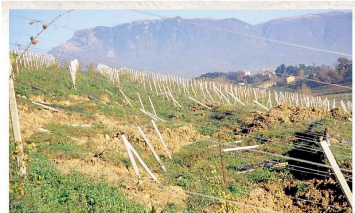
Smottamento per mancato convogliamento e drenaggio delle acque.
