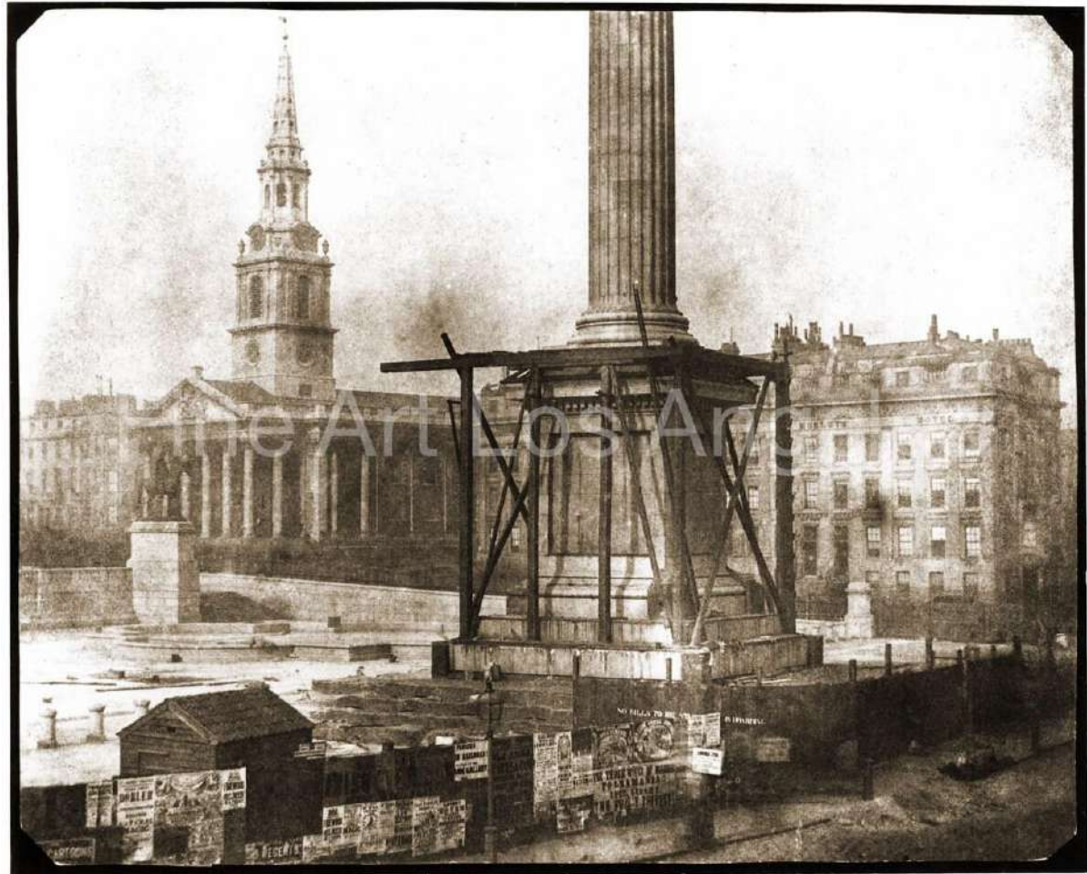
W. Talbot, La colonna Nelson in costruzione, 1844
