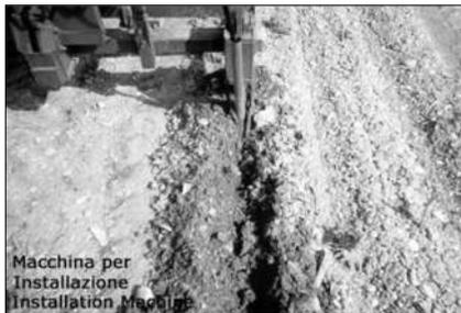
**L'interramento si realizza mediante un vomere al quale viene saldato un tubo-guida che canalizza le tubature e permette il loro interrimento in profondità**
