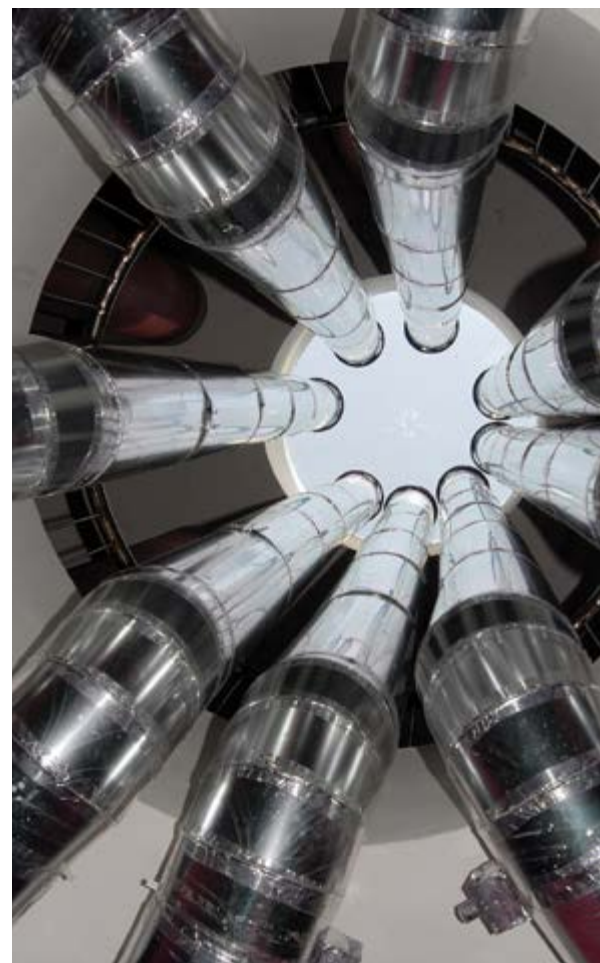
I lucernai per la luce e le prese d'aria per la coibentazione della cantina di Salcheto
