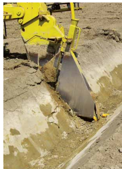
FOTO 6. SISTEMAZIONE DEI DRENAGGI IN TERRENI DI PIANURA
