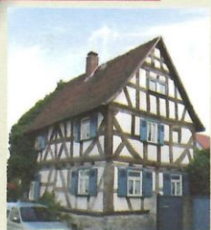
Das Fachwerkhaus = casa ad intelaiatura di legno.
